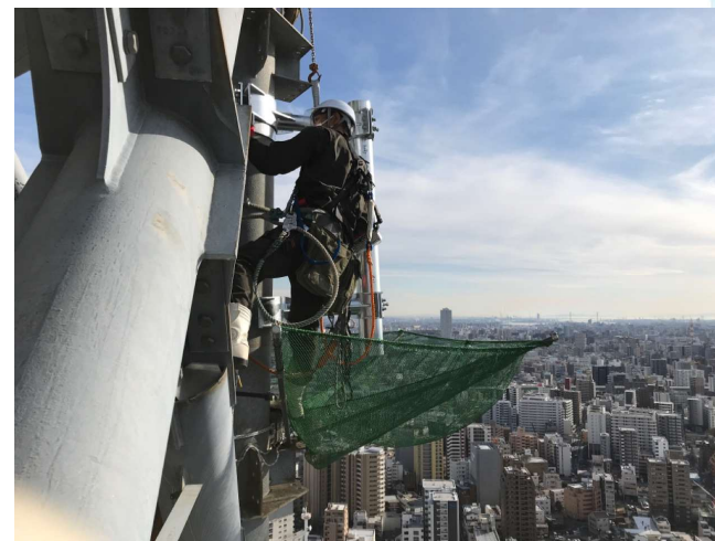
携帯電話アンテナ取付作業
