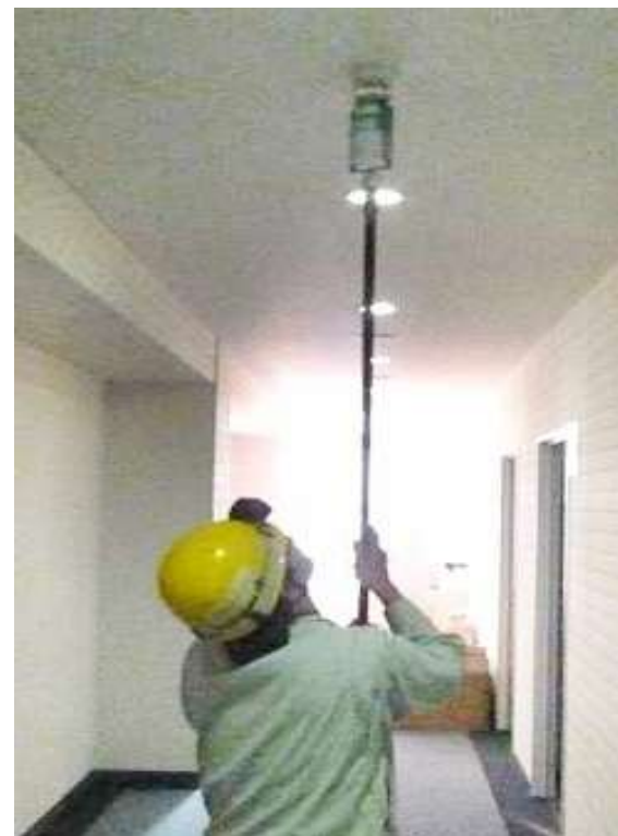
感知器点検作業
