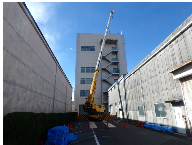
クレーン作業
