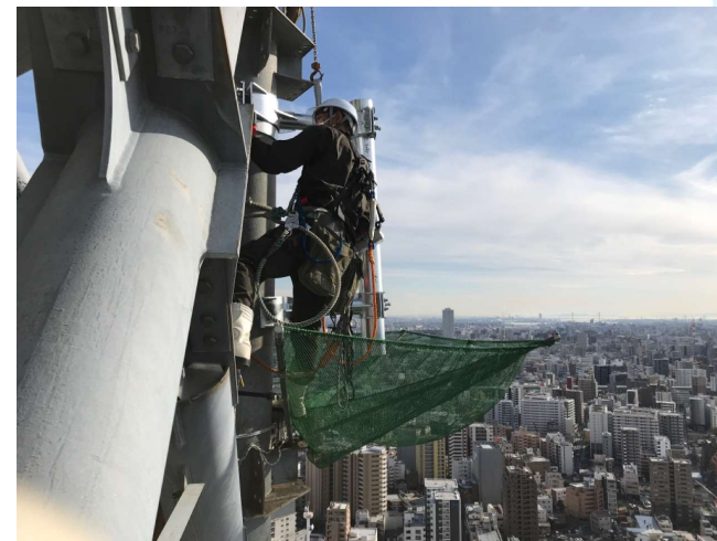
携帯電話アンテナ取付作業
